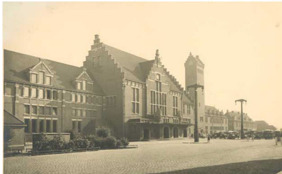
Afb. 2.10 Opname uit 1928 van het huidige station; gezien naar het zuidoosten.
